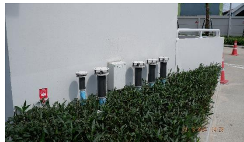
ภาพที่ 2.1-35 ระบบกำจัดก๊าซมีเทน
