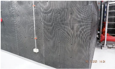
ภาพที่ 2.1-23 การติดตั้งแผ่นกันเสียง ภายในห้องเครื่องสูบน้ำ
