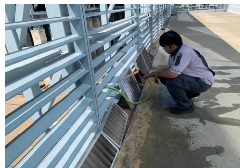
ภาพที่ 2.1-49 การทำความสะอาดแผ่นกรองอากาศ
