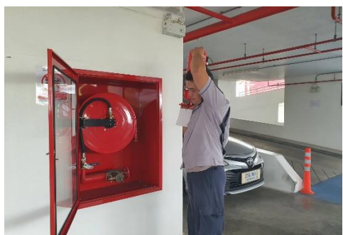
ภาพที่ 2.1-40 การตรวจสอบอุปกรณ์อัคคีภัย
