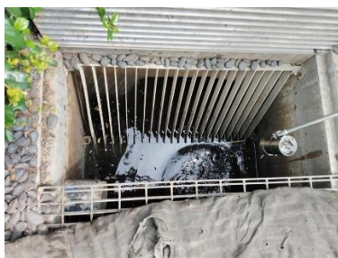
ภาพที่ 2.1-11 ตะแกรงดักมูลฝอยบริเวณบ่อพักน้ำทิ้ง สุดท้ายก่อนปล่อยออกนอกโครงการ
