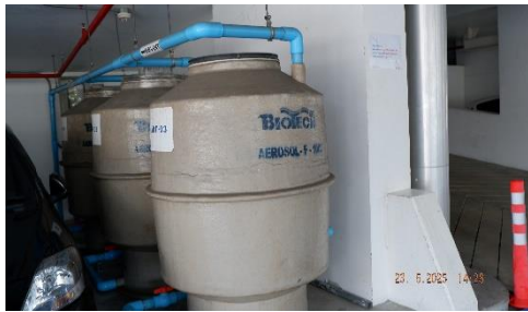
ภาพที่ 2.1-36 ระบบบำบัดละอองลอย (Aerosol)
